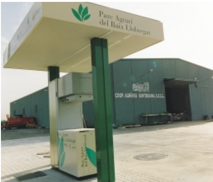
■ La benzinera està instal·lada al recinte exterior de la cooperativa.
