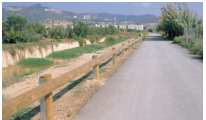
■ La barana de protecció respecta l'entorn natural
